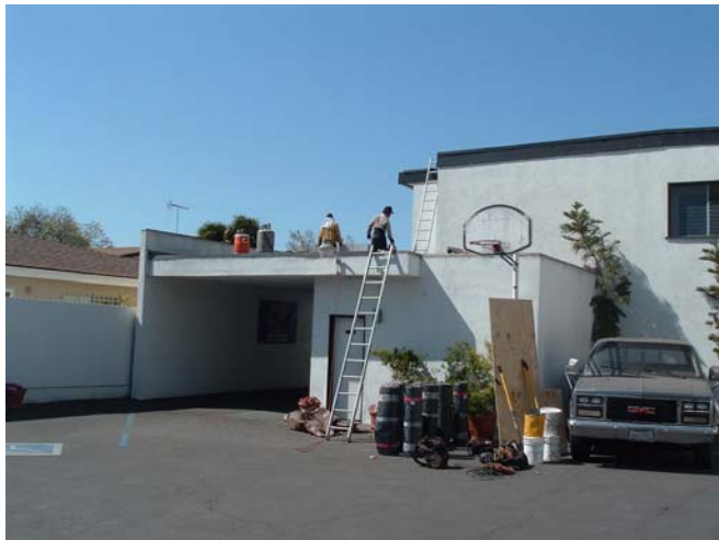
工人安裝新的屋頂，4-13-06
